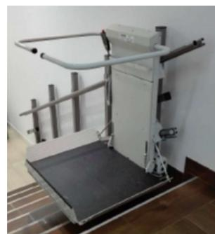
La instalación de la plataforma salva-escalera va montada sobre una guía-carril por la cual se deslizaría la plataforma y un punto de toma de corriente a acometer sobre el cuadro eléctrico existente. Algunas de las características de la plataforma salva-escaleras son: dos paradas, dimensiones, capacidad y potencia suficiente para elevar a usuarios con una silla de ruedas con motor, plegable de forma automática, con brazos de seguridad y rampas de acceso automáticas.
